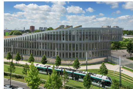
Die an der Straßenbahntrasse entlangführende Hauptfassade besteht aus einem riesigen verglasten Riegel. Rhythmisiert wird er durch eine Reihe von vertikalen Sonnenschirmen aus perforiertem, blankgeglühtem Edelstahl der Sorte Uginox 304L (EN 1.4307) in der Oberflächenausführung Bright. Sie bilden
